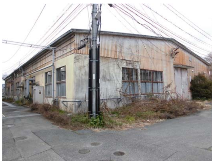
図 15：関西センター 機械材料試験工場及び付帯設備
