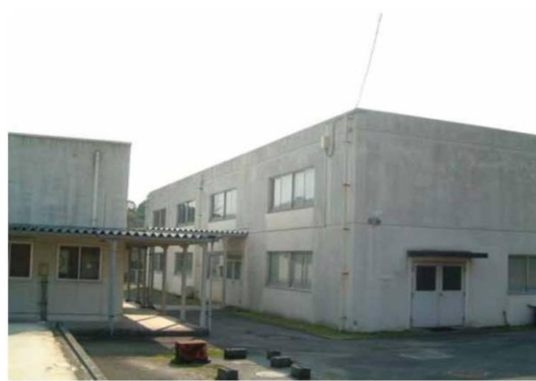
図 14 直方サイト第 1 実験棟
