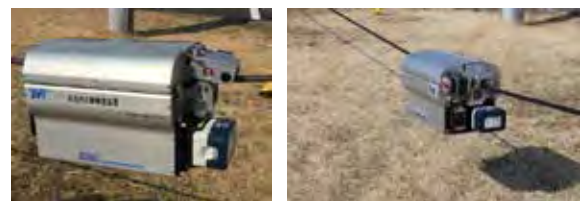
配電線自走式検査試験風景
