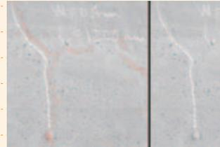
パターン認識で、コンクリート構造物のひび割れを自動検知。白線が人による確認、赤線が自動検知。
