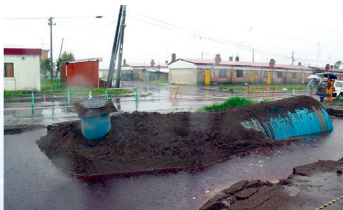
写真2 十勝沖地震の発生直後に行われた、現地調査風景。 揺れがもたらす液状化現象で地下タンクが浮き上 がっています。地震はいろんな形で私たちに被害 をもたらします。
