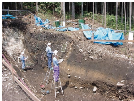
写真5 トレンチ調査のようす。 活断層のある場所を推定し、溝状に地面を削り取り、過去の地震を起こした地層ずれを観察し詳細に記録します。
