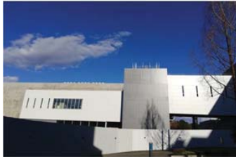
(令和2年1月末時点、建設中写真)
