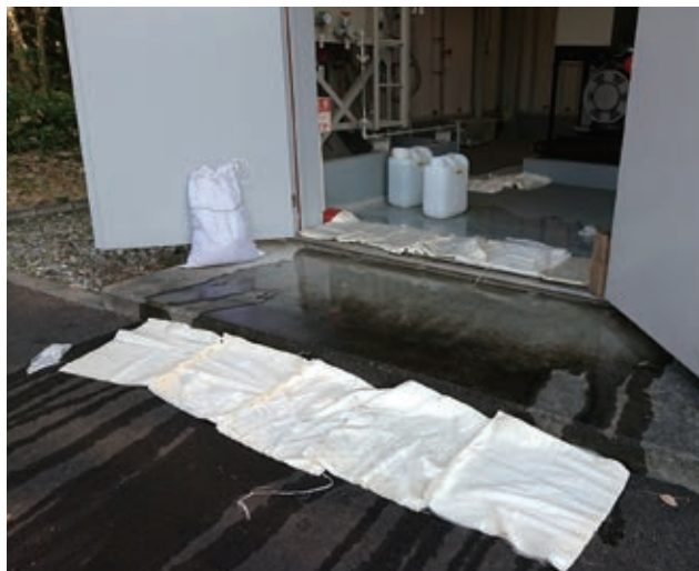
非常用自家発電機室内で燃料タンクに軽油※を補給中、軽油が漏えいして室外へ流出したことを想定した環境事故訓練の様子(※訓練では水を使用しています。)
