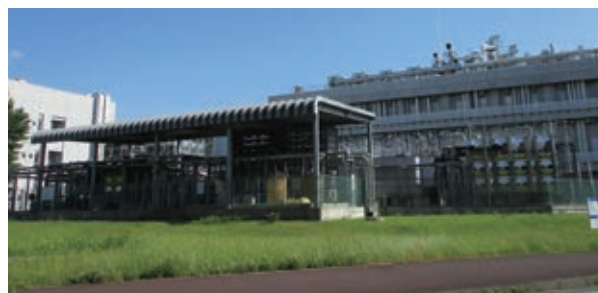
つくばセンター内の廃水処理施設
