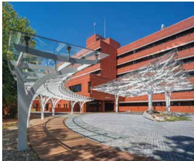
刷新した本館玄関まわり車寄せ
