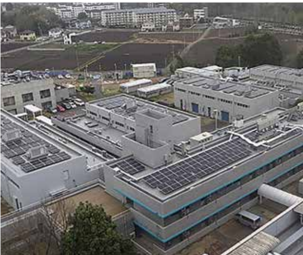
「創エネ」として設置した西4群の屋上太陽光発電パネル179kW (一般住宅35戸分。5★ZEBを取得した西-4A棟を含む)
