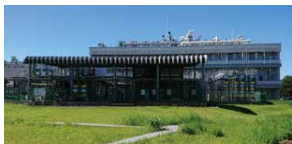
つくばセンター内の廃水処理施設
