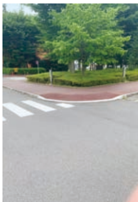
歩行通路の段差解消
