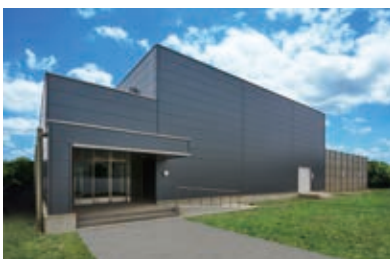
AIデータセンター棟外観
