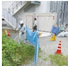
刈払機による除草作業の様子
