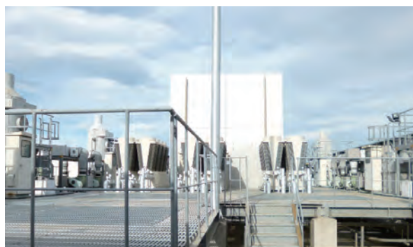
つくば中央(第3事業所)の熱源機: ガス式の冷温水発生機(上)から電気式モジュール空冷チラー(下)へ改修を行いました。 本改修により、改修前に比べ約54%の省エネルギー効果が期待されます。
