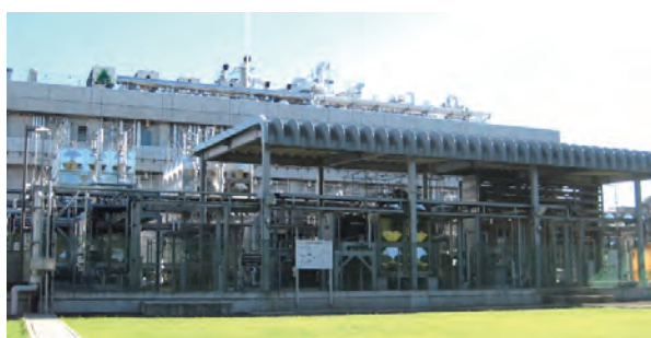
つくばセンター内の廃水処理施設
