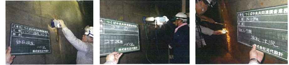
写真 詳細調査実施状況
