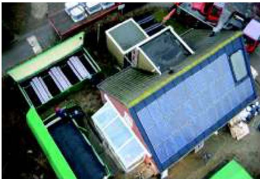
図 4-19 オランダにおける More Microgrids 実証施設（住宅）の外観 [4-27]
