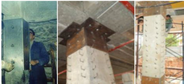
<鋼ジャケットによる耐震強化>
