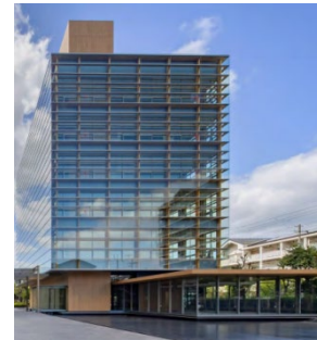
＜タクマビル新館(柱、壁)＞
