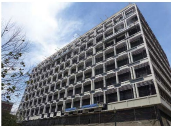
<テキサス州ヒューストンのダウンタウンにある10階建ての官庁ビル>
