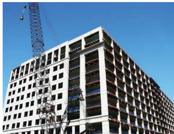
<ワシントンDCのにある鉄筋コンクリートのオフィスビル>
