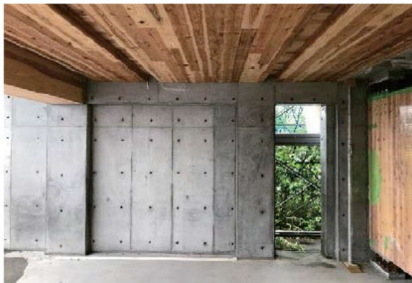
RC-CLT合成床版のモックアップ
