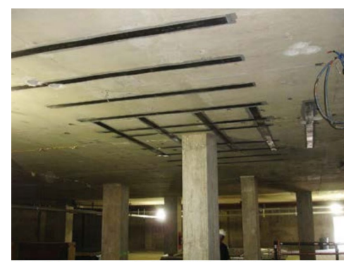
< 柱周囲のスラブに CFRPラミネートが設置された >
