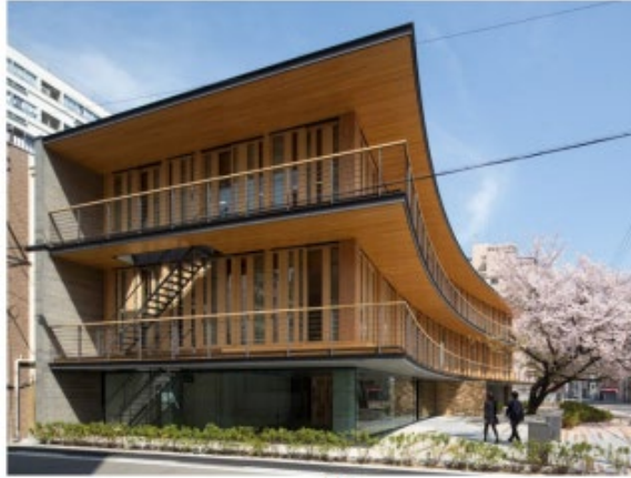
<大阪木材仲買会館(柱・梁)>
