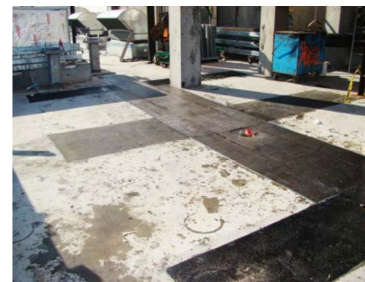
< 追加荷重をサポートするために、屋根スラブに接着されたCFRPファブリック >
