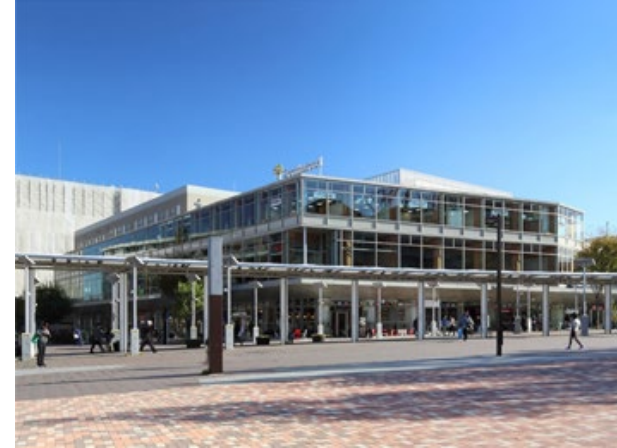
<サウスウッド(柱・梁)>
