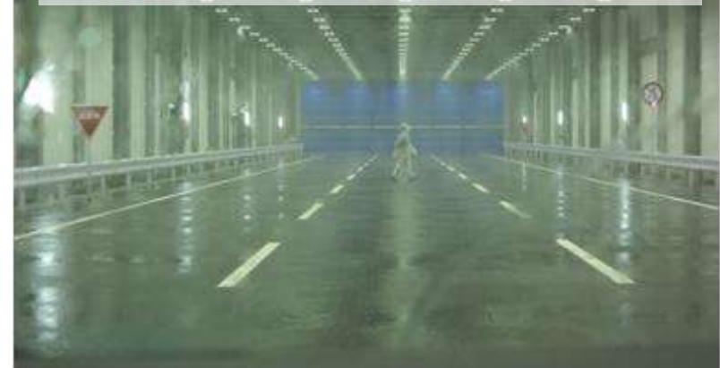
特異環境試験場内で降雨時
