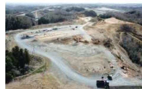
ADAS試験場造成工事 2021年3月17日撮影
