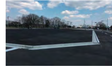
走行試験路 磁気マーカー設置
