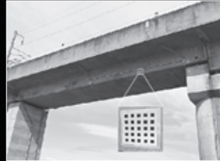
カメラ撮影による橋の変形測定
