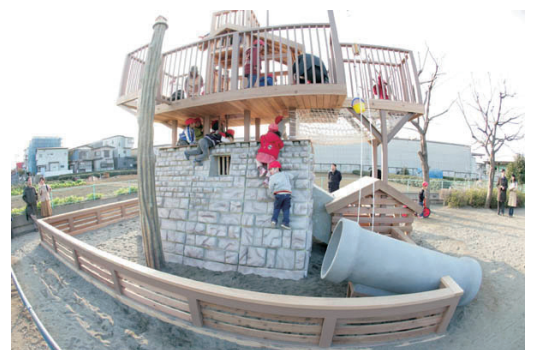
登り部分を工夫した新しい遊具の製作と設置
