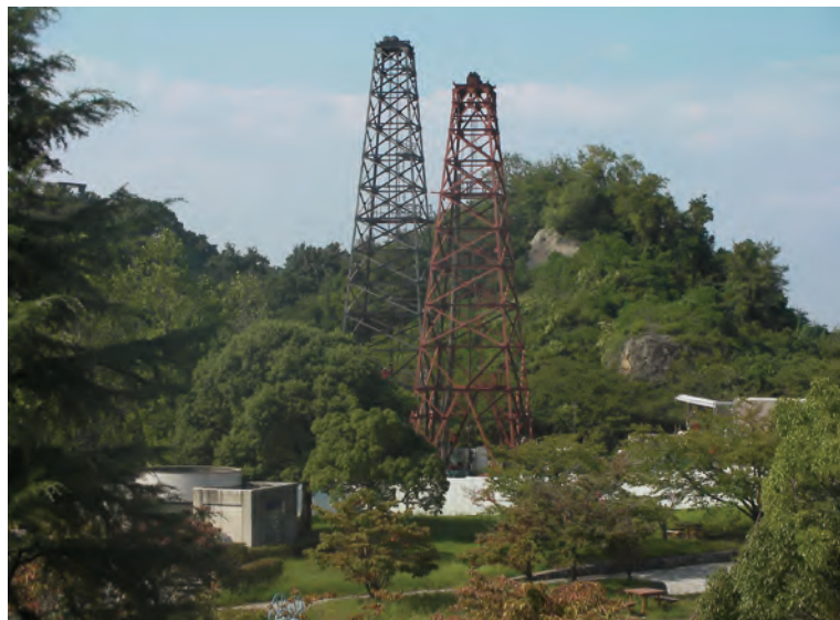
▲産総研の観測用井戸（建設中。完成後はやぐらを撤去）
