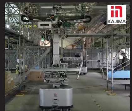
天井施工ロボット
