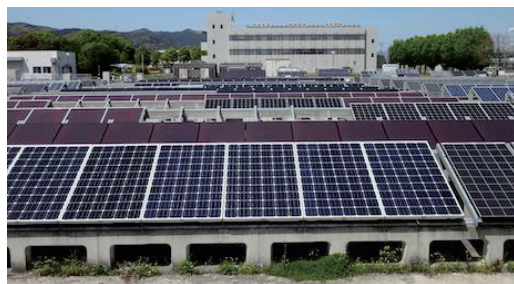
太陽光発電モジュールの屋外曝露試験設備
