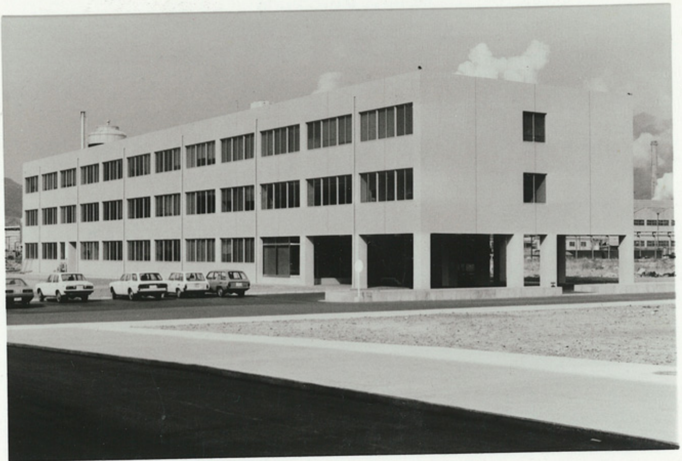
完成した中国工業技術試験所の研究本館、起潮装置のゲート、起潮室ポンプ
