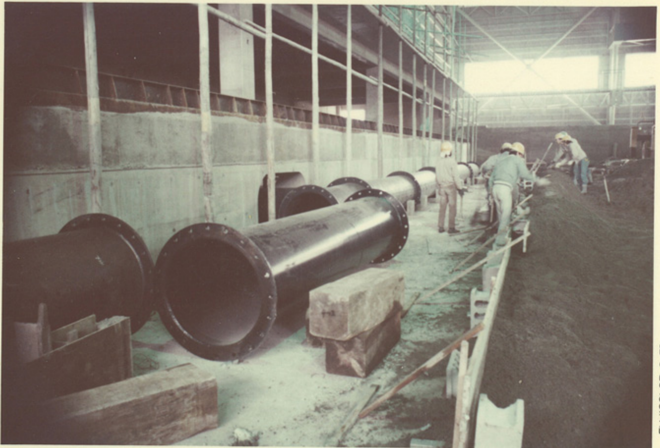
起潮装置の配管敷設、上部クレーンの取り付け工事、完成間近の水理実験場遠望
