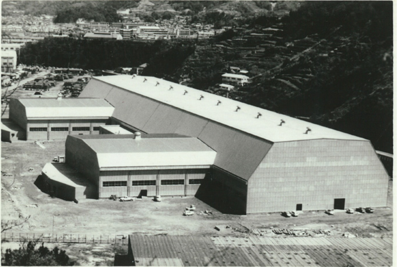
完成した瀬戸内海大型水理模型実験場の全景
