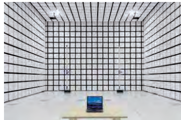
電磁環境規制に対応した10m法電波暗室
